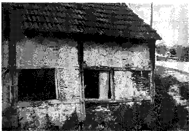
N° 52. — HABITATION : payotadje , cloisonnage, servant d'assise au plafonnage (Photo Lucienne LÉONARD).
