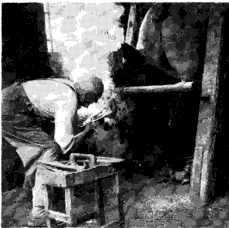
N° 33. — MARÉCHAL-FERRANT : en l' tinant avou lès deûs d'bouts d' l'étrivière plantès dins deûs dès traus, li marchau présinte li flèr tot tchôd su l' sole ritaytè ; li fumère monte do l' sole qui igne ; su li d'vant, li buèssè à claus, en le maintenant au moyen des bouts de la tenaille fixés dans deux trous du fer, le maréchal applique celui-ci sur la sole retaillée : la fumée monte de la sole qui brûle en répandant une odeur âcre ; au premier plan, la boîte à clous (Photo Joseph MARCHAL).
